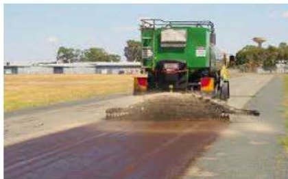
1.1-Расм. Бетон қопламани шимдириш.
