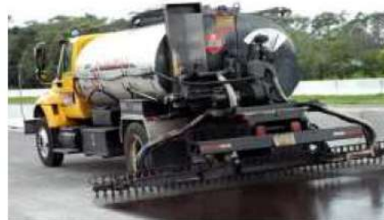
1.1-Расм. Бетон қопламани шимдириш.
